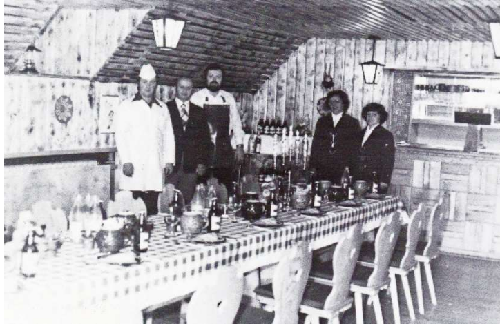
Stülpnerstube, eingerichtet in Eigenleistung
